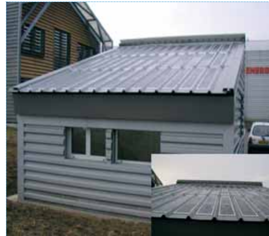
Composant photovoltaïque intégré et monitoré en conditions réelles
