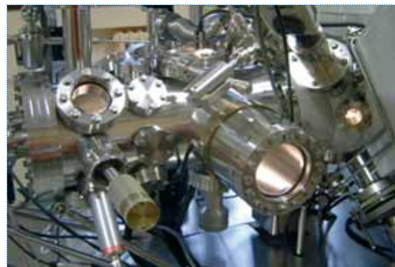
Équipement de caractérisation de surface : chambre ultraviolette de transfert et de préparation des échantillons.
